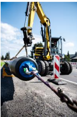
Der Rohrstrang wird vorbereitet für den Einzug mittels einer Zugwinde mit einer Zugkraft von 100to
