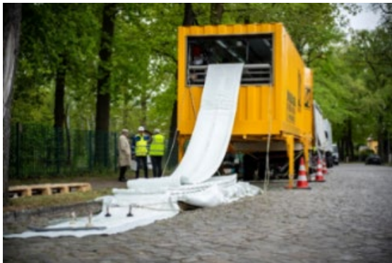
Mobile Tränkfabrik der D&S Rohrsanierung für die Liner-Imprägnierung
