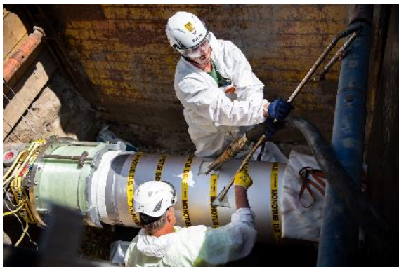
Montage des Dampfauslassventils in der Zielbaugrube, D&S
