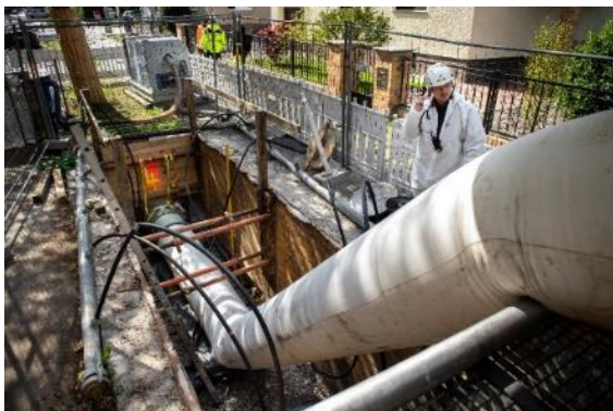
Das Schlauchlinermaterial ist außerordentlich bogengängig, D&S
