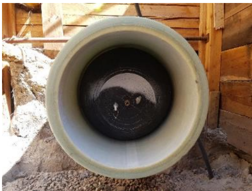
Nach der Härtung entsteht beim BlueLine-Verfahren ein neues Rohr im Altrohr, D&S
