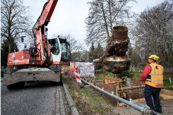
Start- und Zielgrube sowie die erforderlichen Tiefbauarbeiten wurden in diesem Abschnitt vom Partner RAKW Rohrleitungs- und Anlagenbau Königs-Wusterhausen ausgeführt
