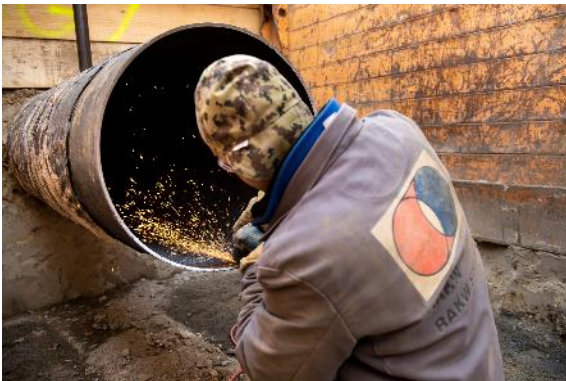
Vorbereitung des Altrohrs zur späteren Wiederverbindung
