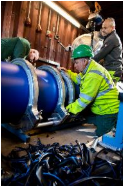
Die einzelnen PE-Rohre werden im Container zu einem Strang verschweißt.
