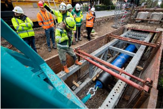
Ankunft des PE-Rohrstranges in der Zielgrube
