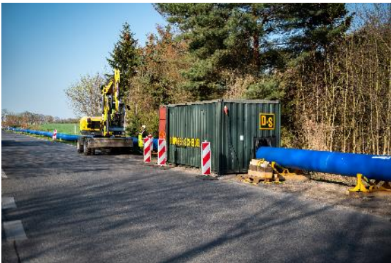
Insgesamt stattliche 775 Meter misst der für die Sanierung erforderliche neue PE-Rohrstrang
