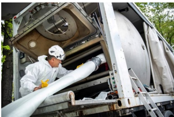
Einführen des getränkten Liners in die Inversionstrommel
