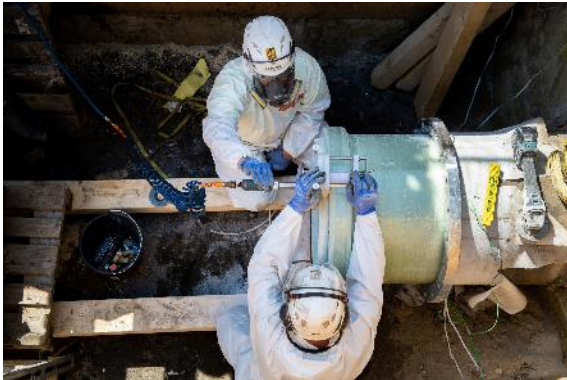
Abschlussarbeiten am GFK-Flansch
