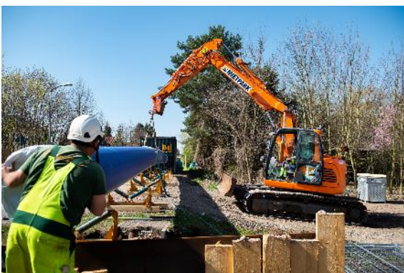
Positionierung der PE-Einzelrohre vor dem Schweißvorgang im dahinter ersichtlichen Container
