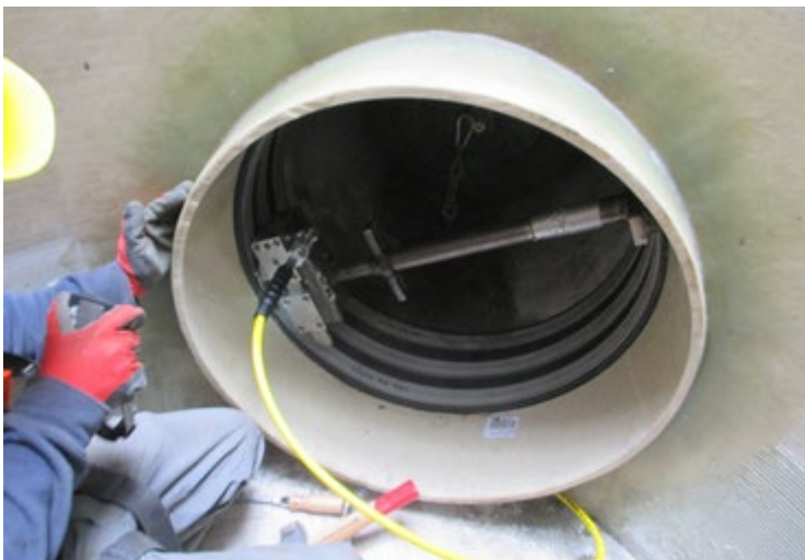
[Foto 02 – Beispiel RedEx Liner-Endmanschette]
