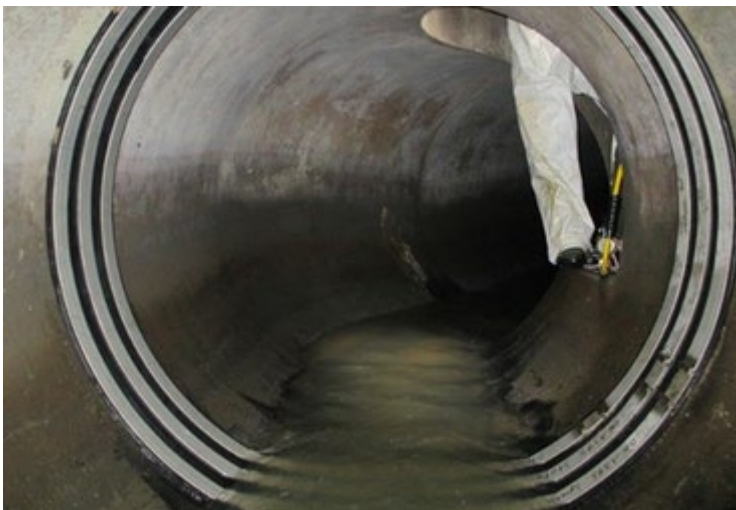
[Foto 01 – RedEx Rohrrinnendichtsystem]
