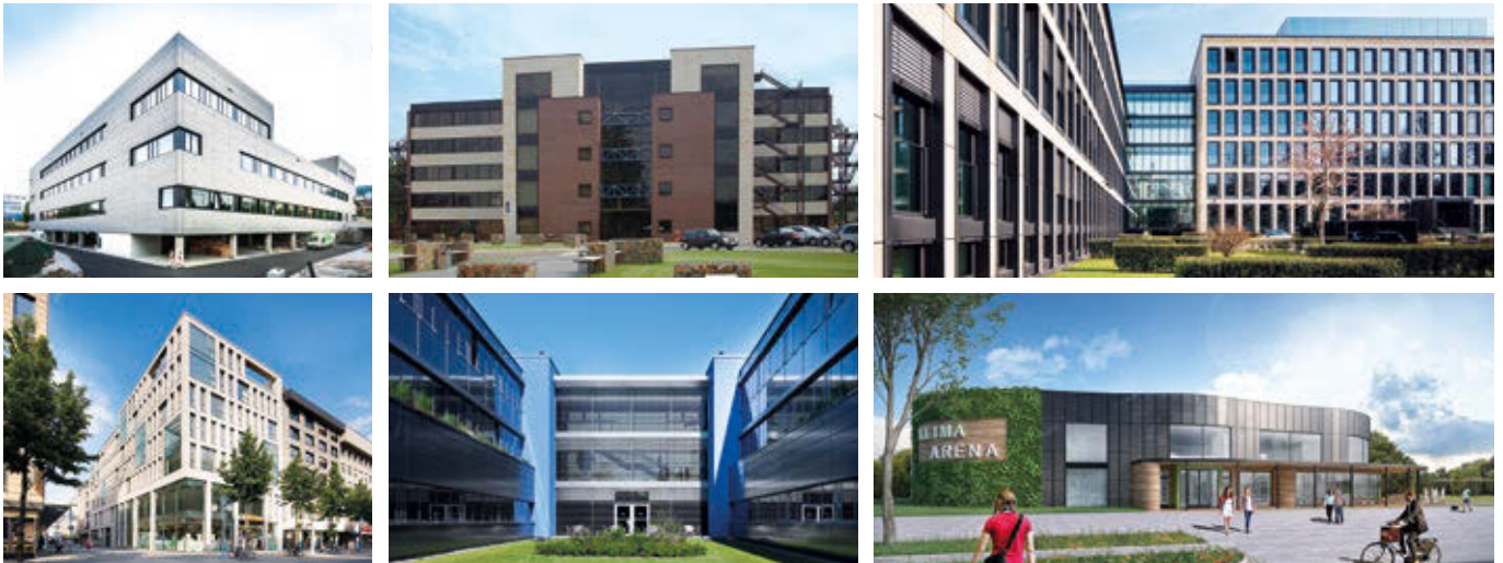
HOCHBAU: Wirtschaft, Verwaltung, Industrie
