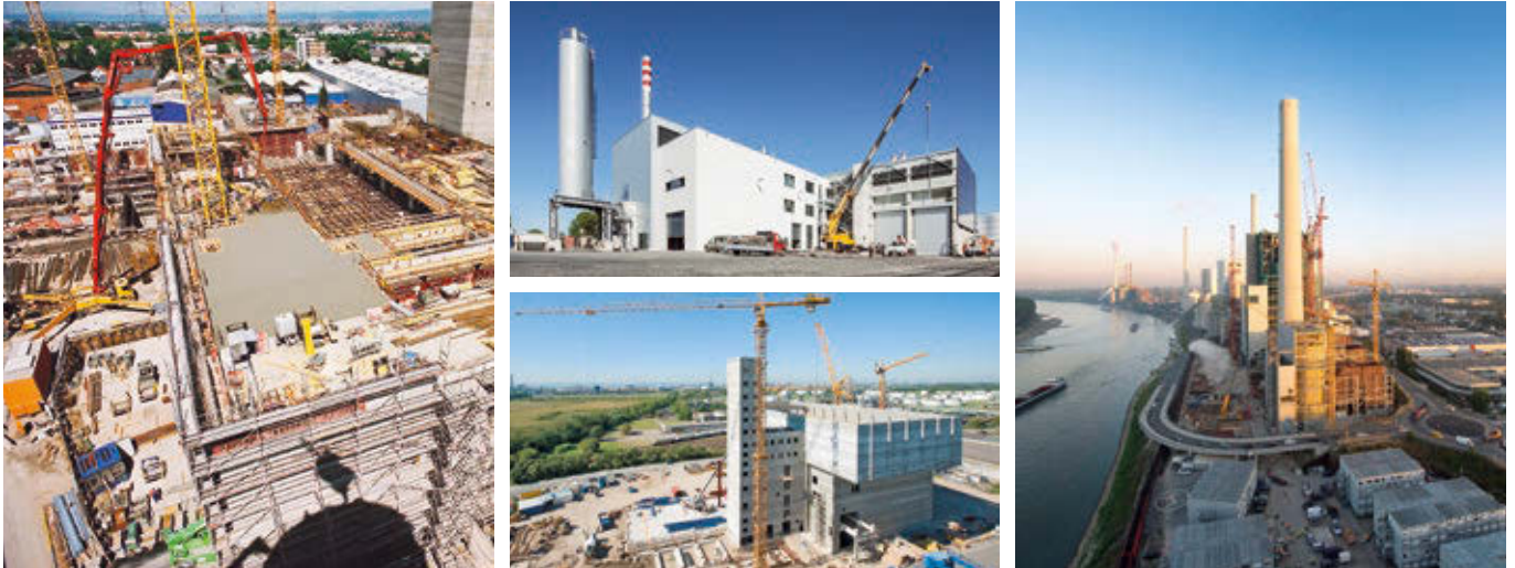
HOCHBAU: Ingenieur- und Industriebau
